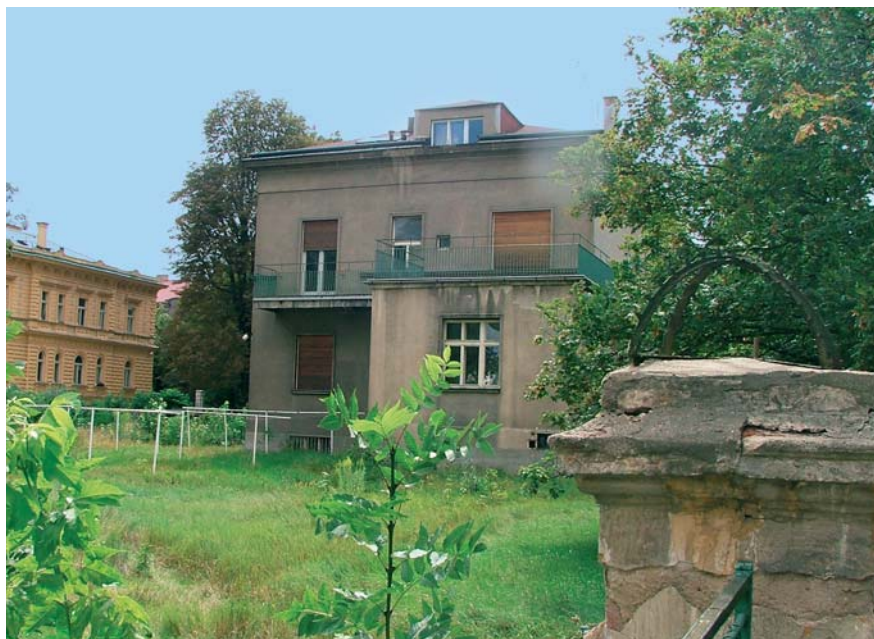
Budova v ktorej bude sídliť slovenské veľvyslanectvo. Pohľad z ulice Na Zátorce
